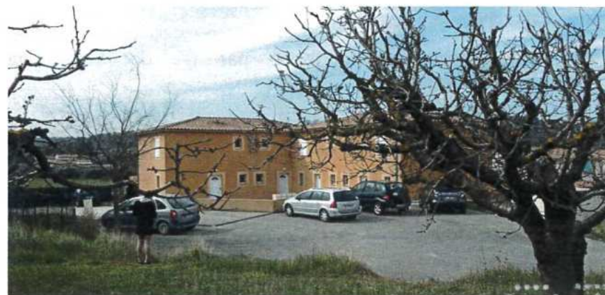
Malemort du Comtat : réalisation de petits collectifs en R+1
