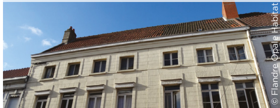
▼ La réhabilitation de ce bâtiment au centre de Bourbourg donnera naissance à un centre d'hébergement pour les Compagnons du Devoir.
