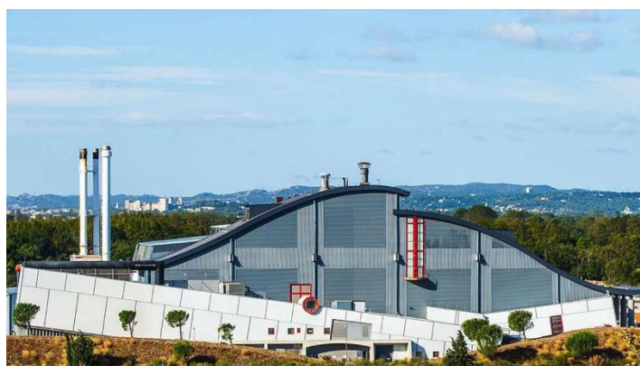
Centre de valorisation énergétique NOVALIE de Vedène
