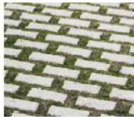
Pavage en béton avec ouvertures de drainage
